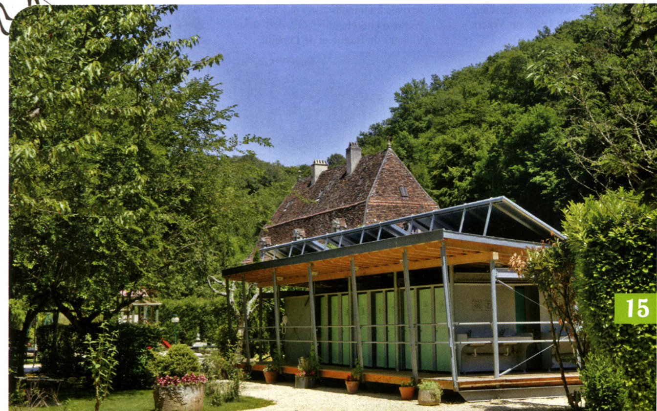
Les blocs sanitaires, avec sur le toit, les chauffe-eau solaires
